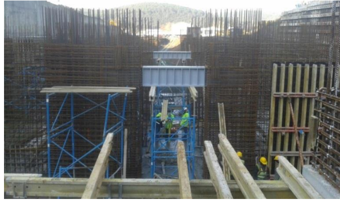
Şekil 2.6 : İnşaat aşamasındaki çelik bağ kiriş ile bağlı perde duvar sistemi (Nurol Life 2015).
